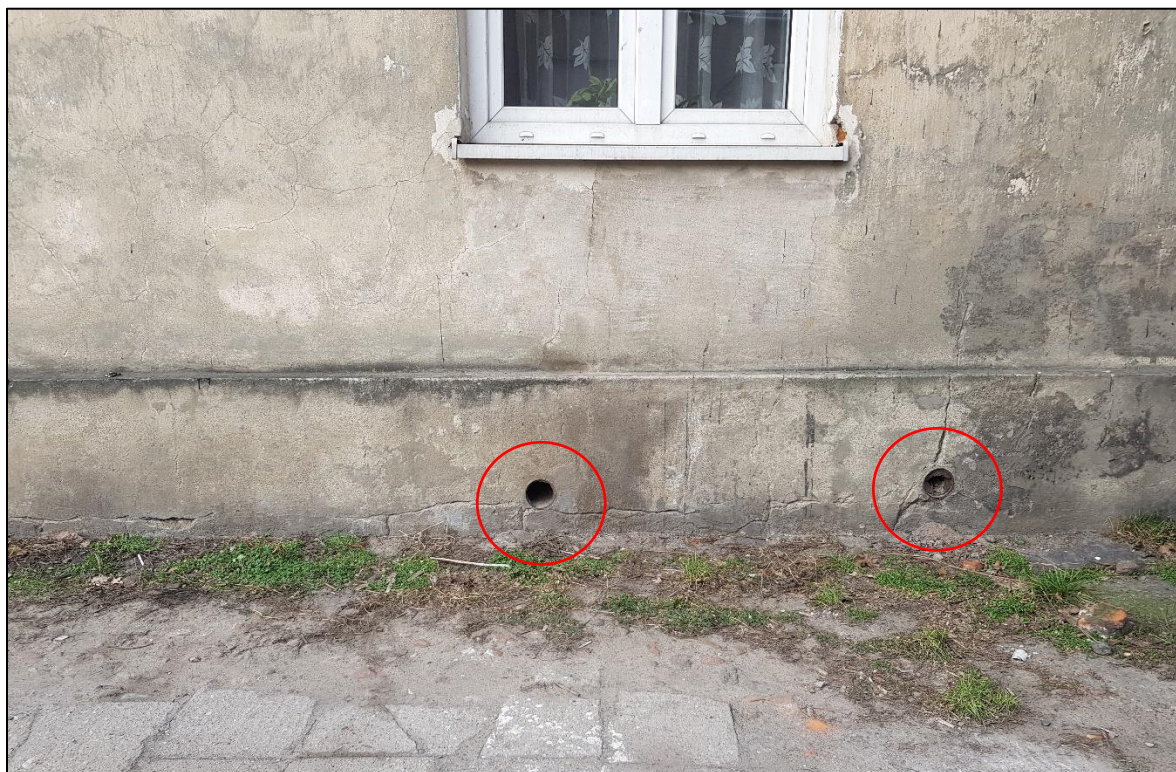
Rysunek 4. Otwór w elewacji budynku, który należy zabezpieczyć.
