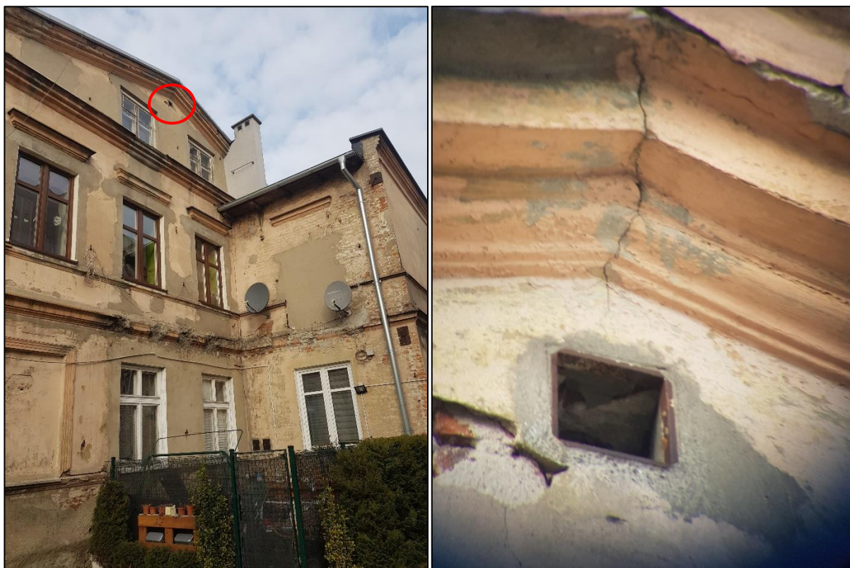
Rysunek 2. Otwór w elewacji budynku, który należy zabezpieczyć.
