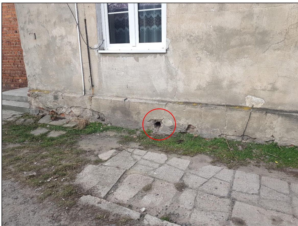
Rysunek 4. Otwór w elewacji budynku, który należy zabezpieczyć.
