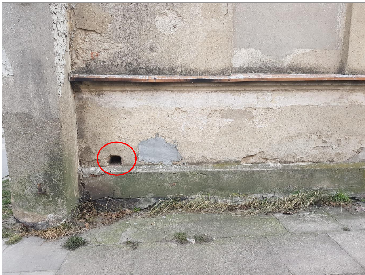
Rysunek 2. Otwór w elewacji budynku, który należy zabezpieczyć.
